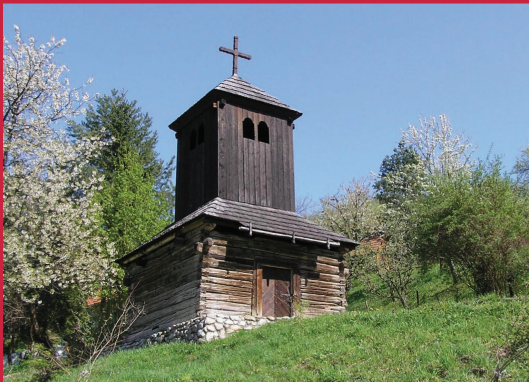
Obnova kultúrnej pamiatky – drevená zvonica v Nitrian- skom Pravne, časť Vyšehradné.
